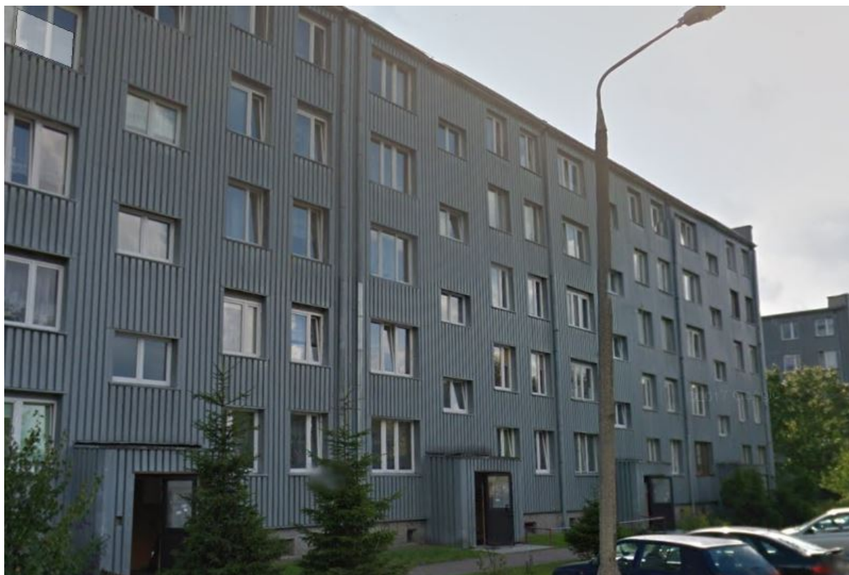
Rysunek 5 Fasada budynku przy ul. Reymonta 20 we Włodawie
