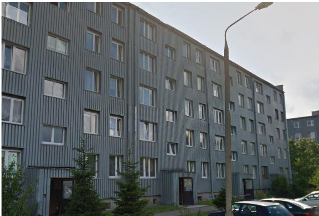
Rysunek 4 Fasada budynku przy ul. Reymonta 20 we Włodawie
