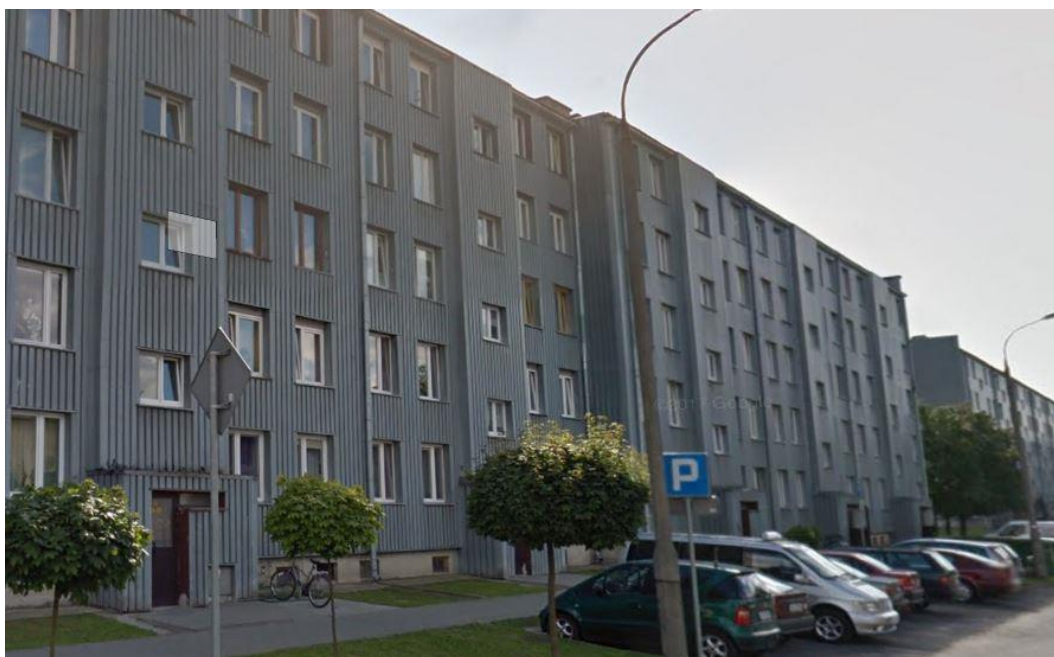
Rysunek 3 Fasada budynku przy ul. Reymonta 10 we Włodawie
