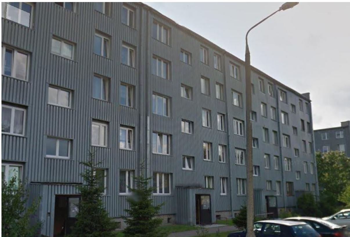
Rysunek 9 Fasada budynku przy ul. Reymonta 20 we Włodawie
